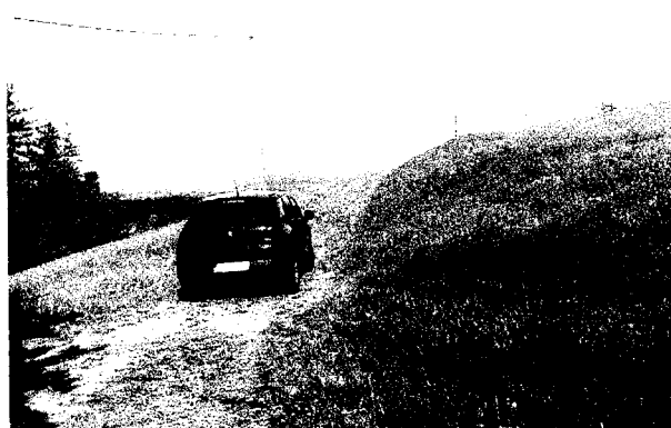
přístupová komunikace na parcele č. 241
