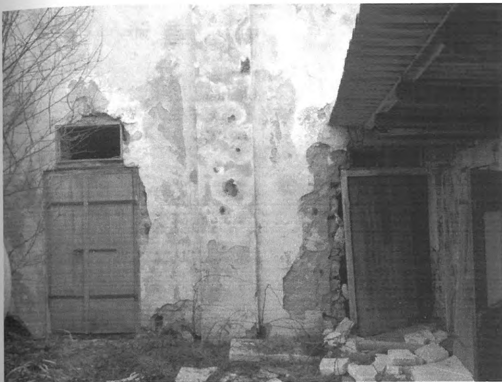
Zemní sklep - kůlna
