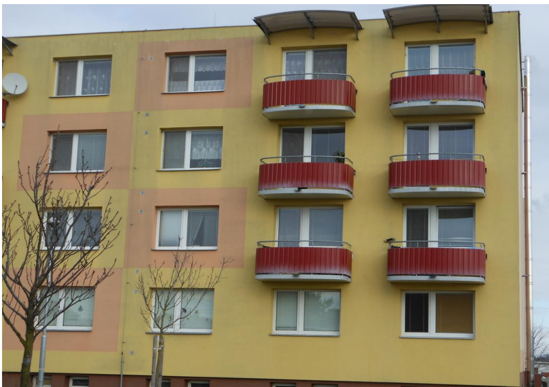
Foto 2 : pohled - jižní průčelí bytového dom č. 522 . Byt je ve 2. NP – vpravo .
