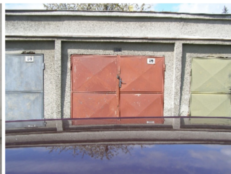
pohled na garáž
