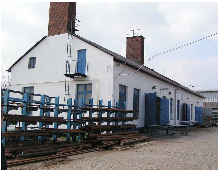
budova č. 12, dílna, lakovna, sklad
