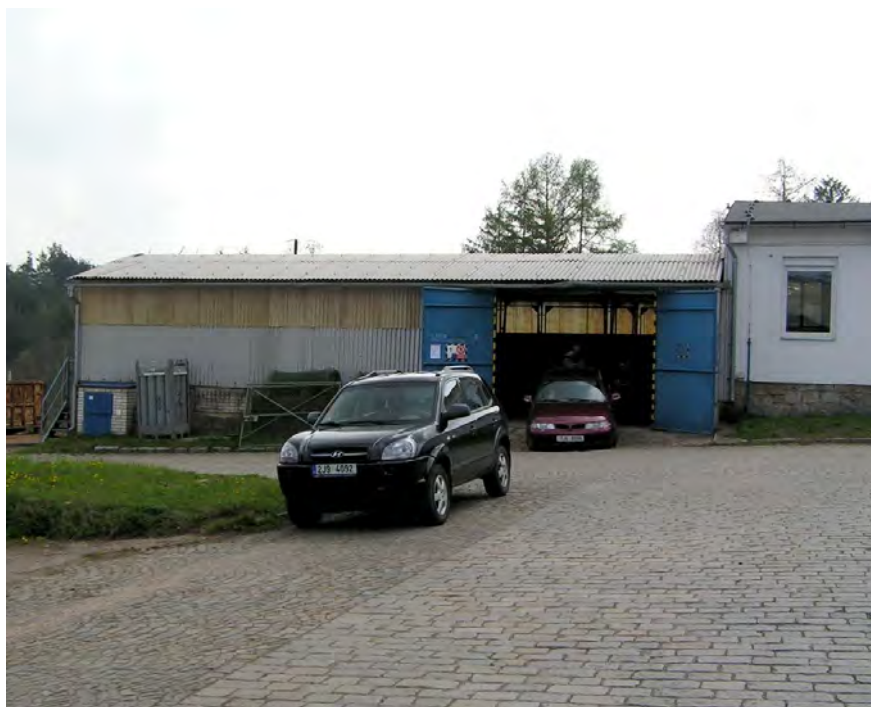
západní průčelí skladovací budovy
