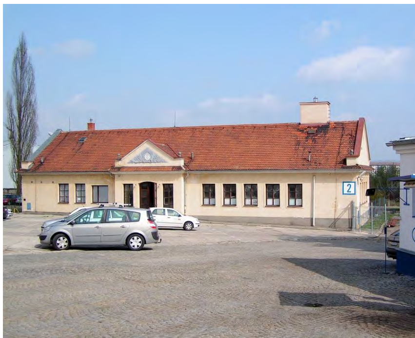
budova č. 2, sociální budova, pohled na jižní průčelí
