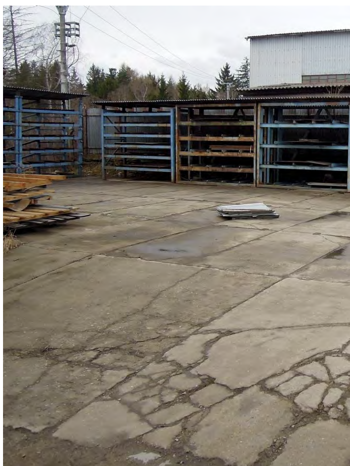
zpevněná plocha betonová
