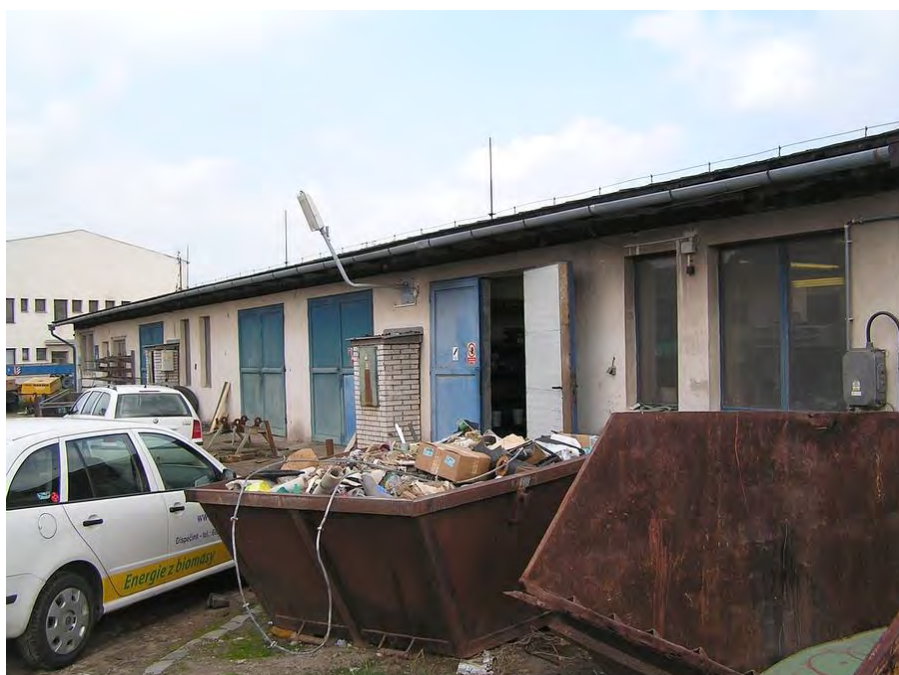
budova č. 10, autodílna, opravna, administrativa
