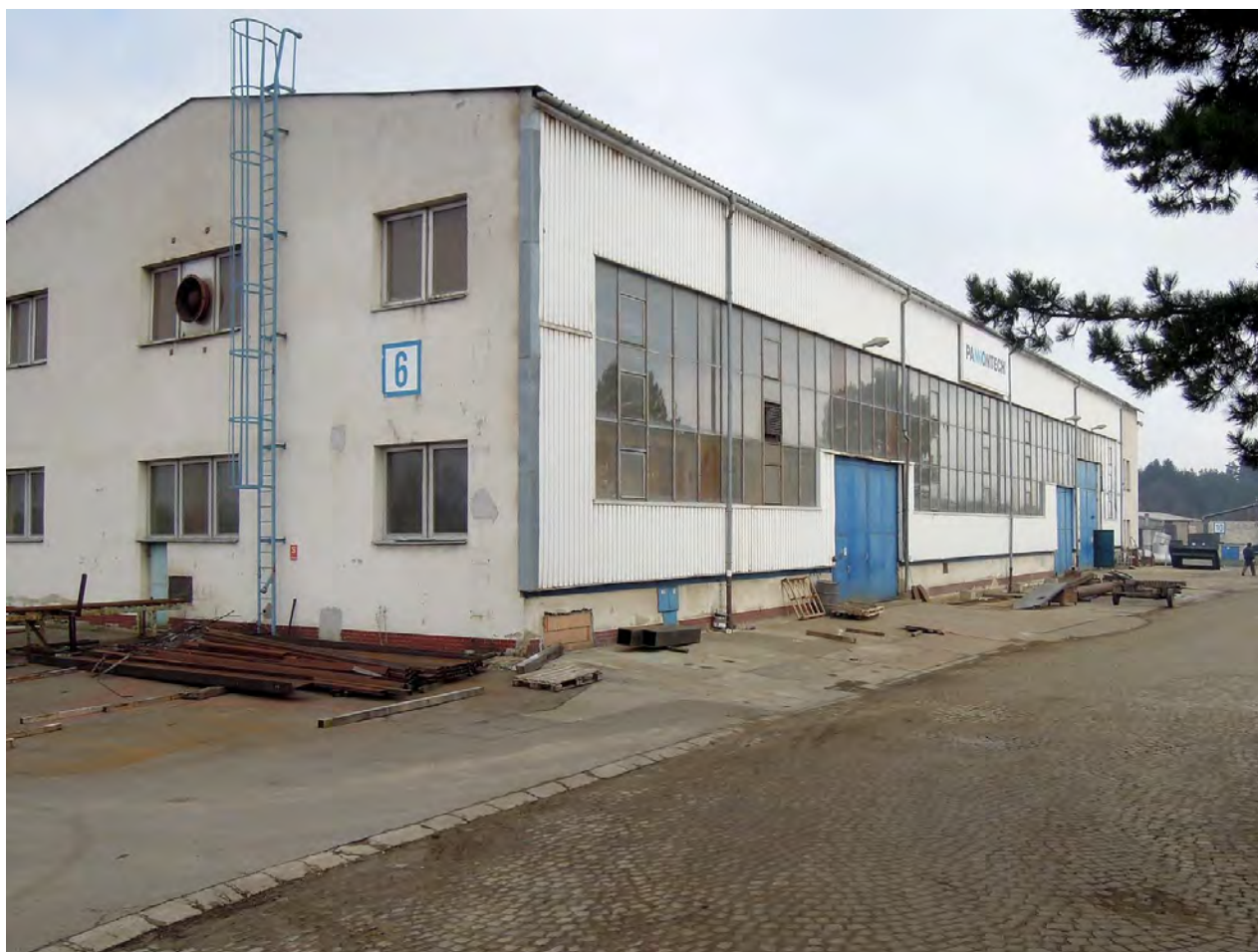
pohled na západní štít a jižní průčelí
