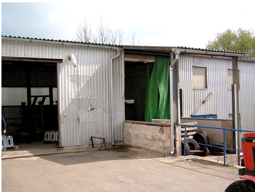
budova kotelny za halou č. 6
