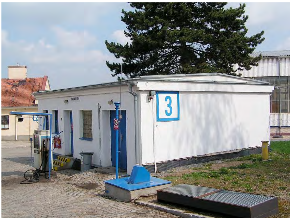
budova č. 3, čerpací stanice, sklad maziv
