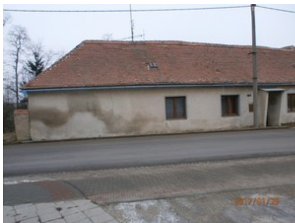
Obr. 1: Levé křídlo z ulice
