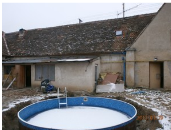
Obr. 4: Levé a pravé křídlo ze dvora
