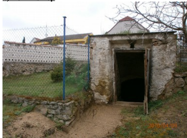
Zemní sklep - zemní sklep zděný nebo betonový (položka 15. 1. přílohy číslo 17 oceňovacího předpisu)
