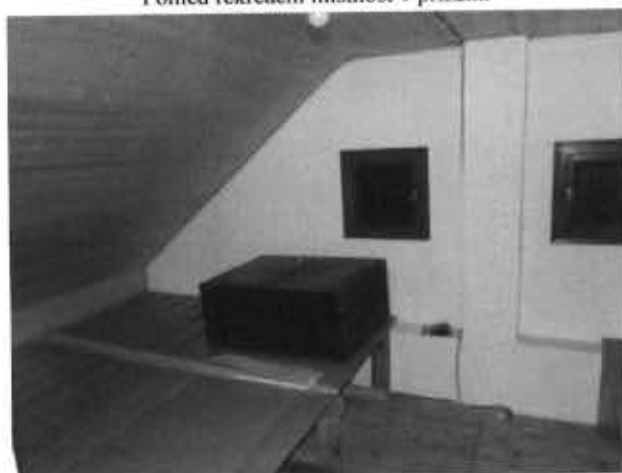
Pohled obytné podkrovní
