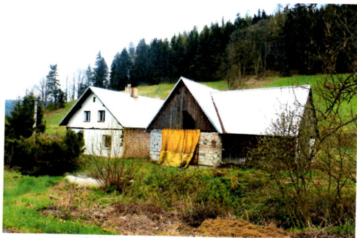
Celkový pohled ze silnice od S
