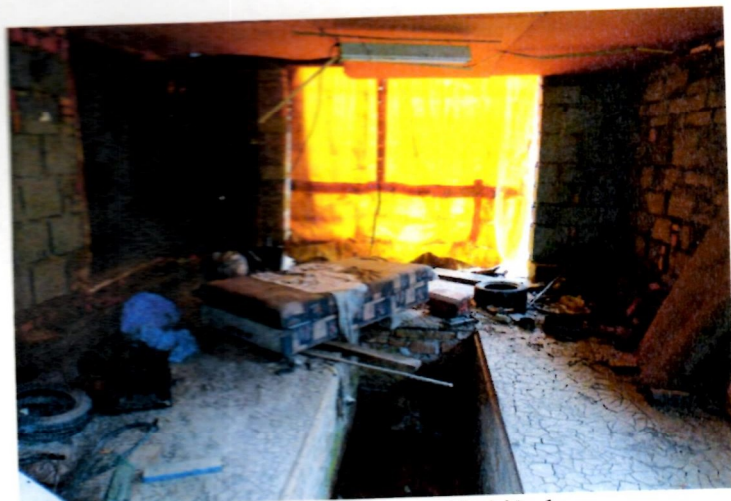
Východní část s montážní jímkou
