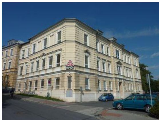
Pohled z jihovýchodní strany
